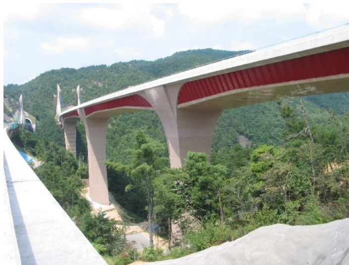
2006年8月施工完了直後撮影
