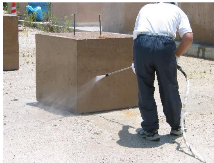
高圧水洗浄をした面
