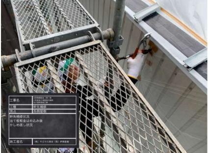
工種: 軒先補修 測点: 西側屋根 当て板板金部材 軒先下部パーツ 嵌め込み後 かしめ直し状況
