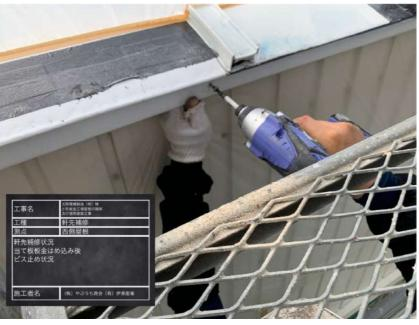
123 工種: 軒先補修 測点: 西側屋根 当て板板金部材 軒先下部パーツ 嵌め込み後 ビス止め状況
