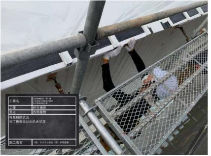
工種: 軒先補修 測点: 西側屋根 当て板板金部材 軒先下部パーツ 嵌め込み状況
