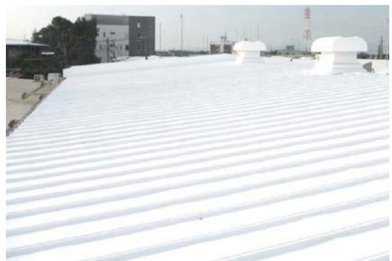
愛知県にある自動車部品工場で、約3000平米の工場は築30年以上が経過しており屋根もボロボロでした。**少しの雨でも雨漏りしてしまうため、製品がサビてしまったり、工場内の設備が劣化してしまったり**していました。屋根の防水塗料を探して試してもみましたが、すぐまた雨漏りするようになり、コストに対して満足できる結果にならず悩んでいました。そんなときに屋根の防水もできる遮熱塗料のことを紹介してもらい、**防水に加えて遮熱もできること、さらに10年間の保証があることが決め手**となり施工をお願いすることにしました。簡単に雨漏りする箇所を示した雨漏りマップを渡して雨漏り箇所を集中的に補修してもらいました。施工後は**雨漏りもなくなり、従業員からは「室内がかなり涼しくなった」という声**が多数上がりました。ボロボロだった屋根がきれいな白い屋根になり、見た目がきれいになったのもうれしいです。
