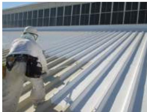
化学工場で、合計約100,000㎡を超える大きさの工場なのですが、経年劣化により、元の**屋根から雨漏りが発生**していました。かぶせ工法で折板屋根を上からかぶせ、一次的に保護をしていましたが、それから10年程度たった時に、その折板屋根も劣化してしまい、**サビがひどく、穴あき状態の屋根**になっていました。かぶせ工法を行っても、穴が開いてしまっているのので、雨漏りも再発してしまいました。そこで、**防錆塗料を塗布しましたが、数年経つと錆が再発したり、はがれてしまったり**して、あまり効果が出ませんでした。何とかならないかといろいろ探していたところ、穴あきがあるほどボロボロの屋根でも再生できる屋根断熱補修.comの特殊遮熱塗料を知って、施工をお願いしました。実際に効果はてきめんで、**5年たった今でも、サビや穴あき、はがれもなく、雨漏りも一切ありません。**
