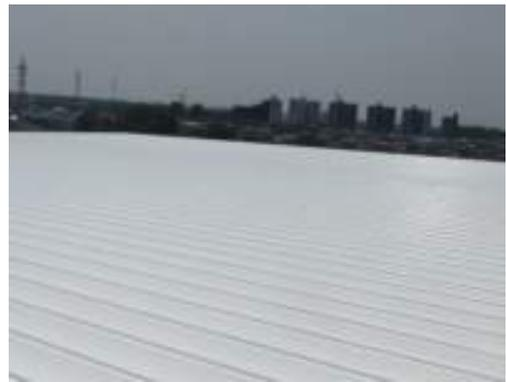
埼玉県にある物流倉庫で薬品類を主に扱っています。薬品倉庫のため、庫内温度が高いと製品に影響を及ぼしてしまいます。そこで、**庫内温度を一定にするために屋根からの入熱を防ごう**と考え、10年前に屋根断熱補修.comの遮熱断熱塗料を施工しました。ふつうの屋根塗料だと7,8年に一度の塗り替えが必要で、屋根断熱補修.comの遮熱断熱塗料では大体10年から15年で塗り替えを行う必要があると事前に聞いていましたが、**10年経過してもキレイなままで効果も持続**しています。10年前に施工した場所と未施工部のそれぞれの温度を計測したところ**10年前に施工した場所が27.8℃、未施工部が47.8℃でした。10年たった今でも19.9℃の温度差**がありビックリしました。
