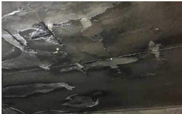
施工前の状態です。内部の屋根材が膨れて、剥がれかけており、雨漏りが発生していることが多いです。
