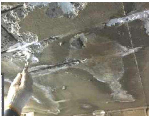
鉄筋のサビ部分に防錆プライマーを塗布します。
