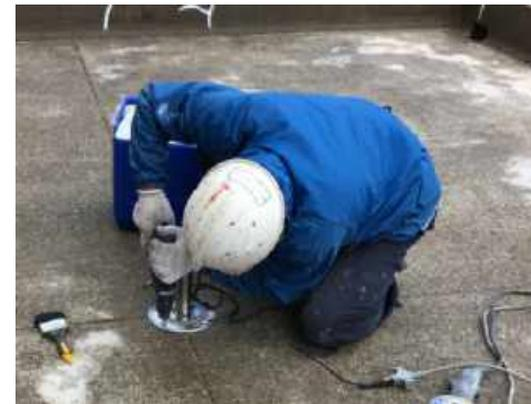
中の湿気を逃がすために脱気筒を設置し、躯体に残った湿気を除きます。
