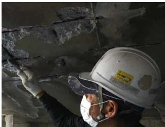
サビケレン作業。鉄筋のサビをとり、防錆プライマーの付着を良くします。
