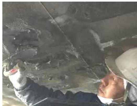
はつり作業した部分を下地調整剤で埋め戻します。
