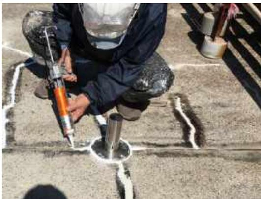
プライマー塗布後、クラック処理部分にコーキングを打って埋めていきます。
