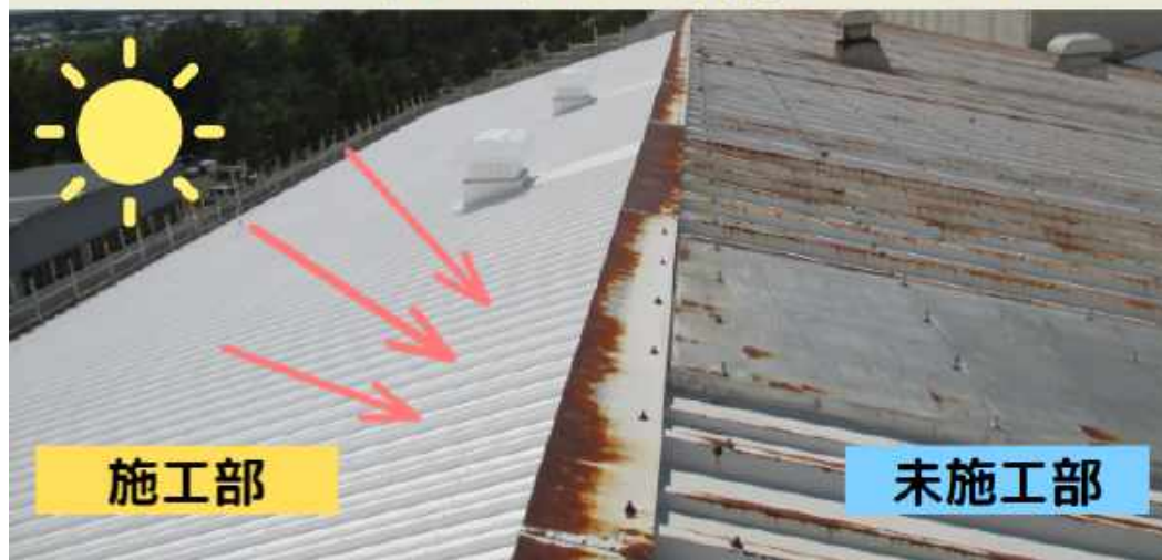
日が当たる側の半面を補修&遮熱施工
