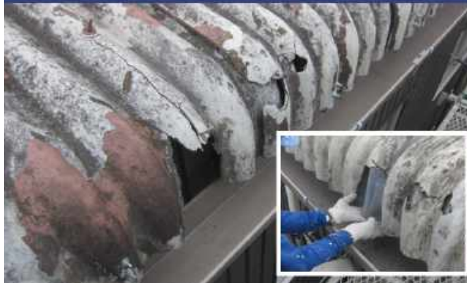
割れたスレートもしっかり補強
