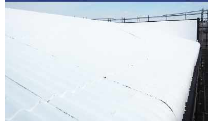
補強&遮熱ができ、外観もきれいに
